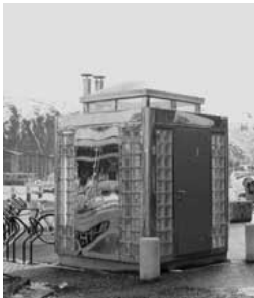
Pumpestasjonen ved Torghuken
