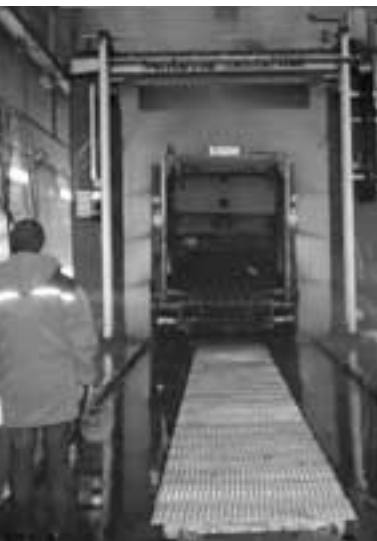
Åpning av vaskehallen 6. april
